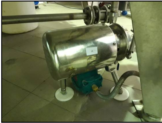
30. Pompa typ SK na wózku z silnikiem 1,1 kW SK na wózku z silnikiem
