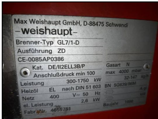
7. Palnik olejowo-gazowy Weishaupt GL7/1 –D, dodana funkcja gazowa 1998 r.
