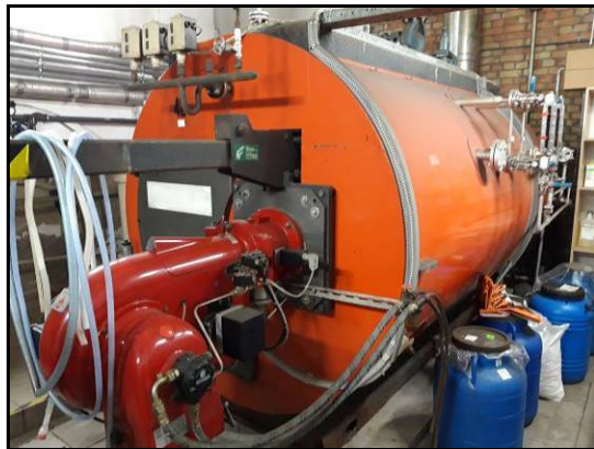
7. Palnik olejowo-gazowy Weishaupt GL7/1 –D, dodana funkcja gazowa 1998 r.
