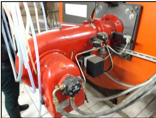
7. Palnik olejowo-gazowy Weishaupt GL7/1 –D, dodana funkcja gazowa 1998 r.
