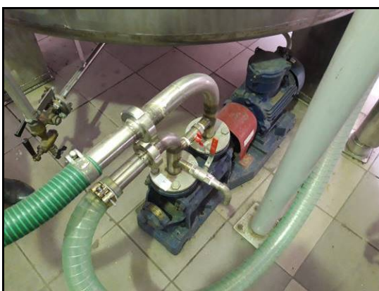
31. Pompa typ SK stacjonarna na podstawie 3,0kW Hydro Vacum
