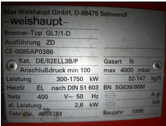
7. Palnik olejowo-gazowy Weishaupt GL7/1 –D, dodana funkcja gazowa 1998 r.
