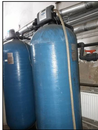
51. Stacja zmiękczenia wody zbiornik na sól h -1,1m Fi 0,7 m 2 zbiorniki z głowicami HST 2007 r. 450 L 60x184 x 2
