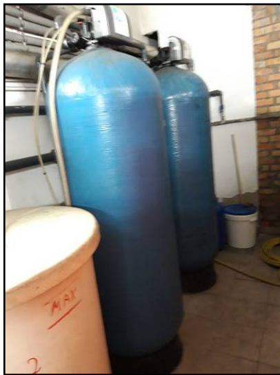
51. Stacja zmiękczenia wody zbiornik na sól h -1,1m Fi 0,7 m 2 zbiorniki z głowicami HST 2007 r. 450 L 60x184 x 2
