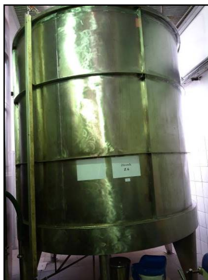
20. Zbiornik stalowy Z6 13.000 l kwasoodporny h-2,6 m , Fi 2,6 m
