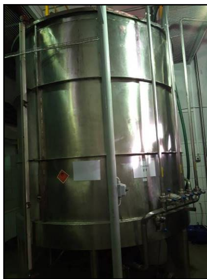
20. Zbiornik stalowy Z6 13.000 l kwasoodporny h-2,6 m , Fi 2,6 m
