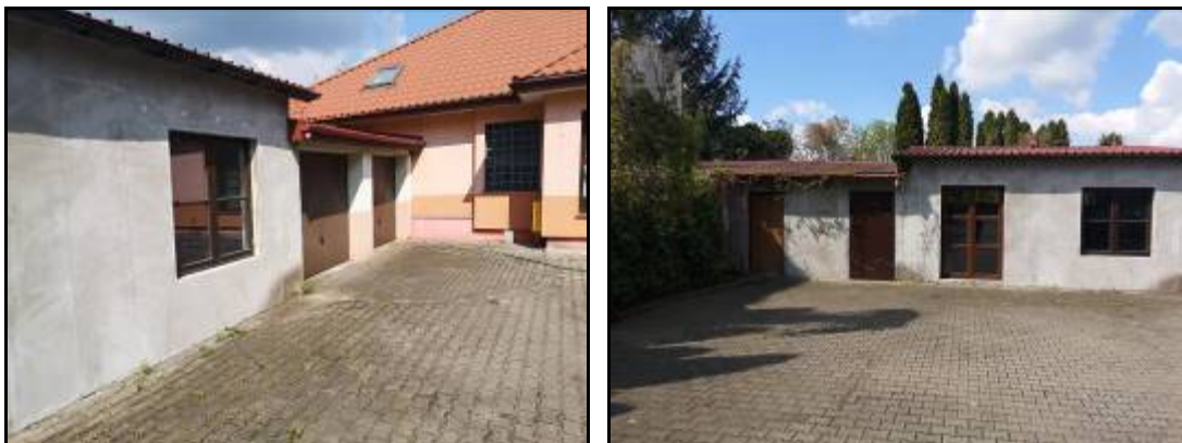
Widok na budynek garażowy przyległy do budynku strzelnicy
